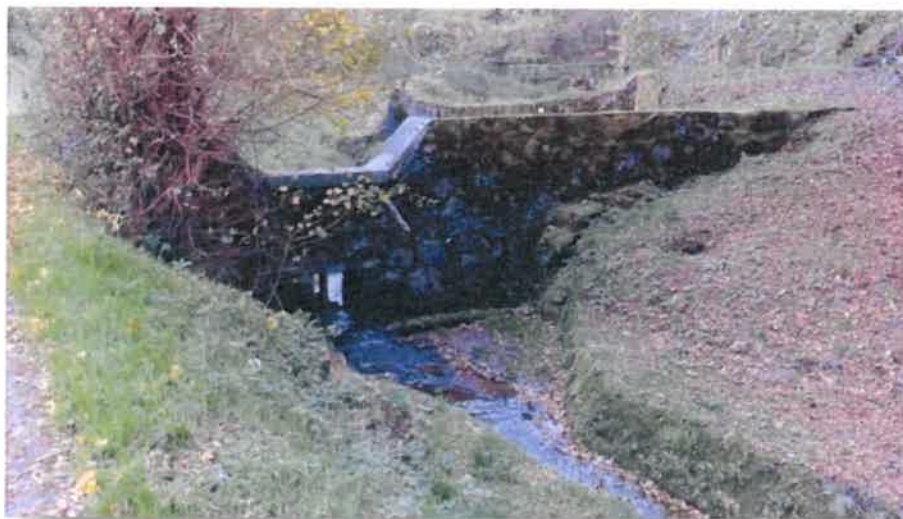
Figura 3 - Briglia di trattenuta esistente posta in località "Valle"
