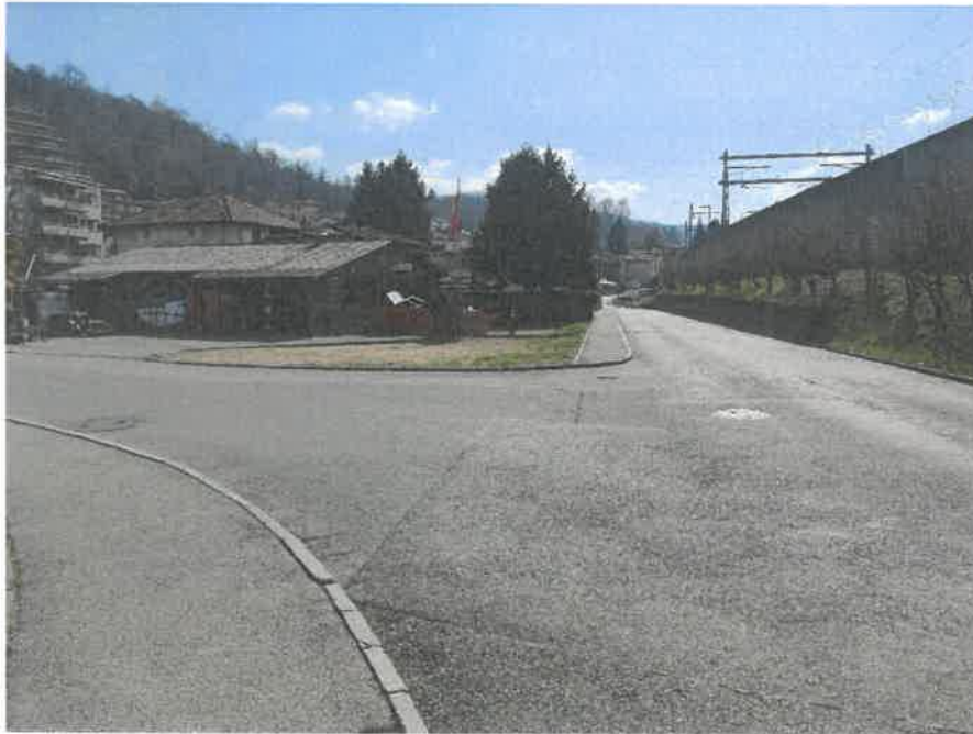
Foto 3 – Incrocio in via alla Stazione, muro di sostegno FFS, pali LC
