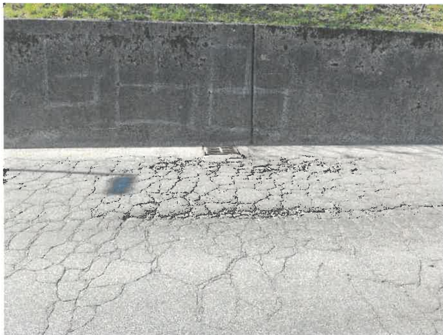
Foto 7 – Pavimentazione In via alla Stazione
