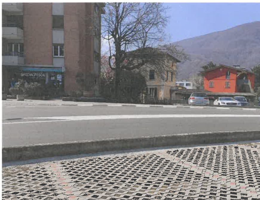
Foto 10 – Piazzale parcheggio Park and Rail, attraversamento strada via Cantonale
