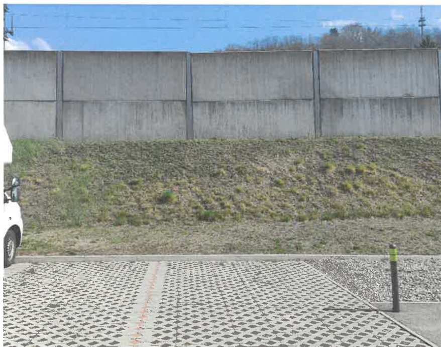
Foto 8 – Piazzale parcheggio Park and Rail, punto di partenza spingitubo
