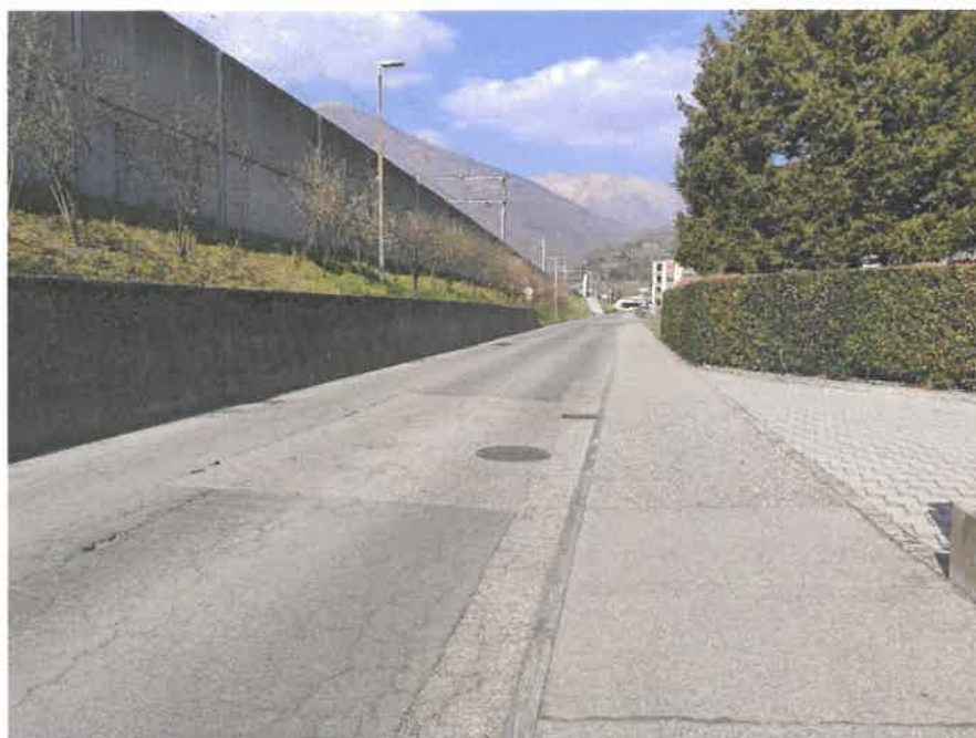
Foto 6 – Punto di attraversamento con spingitubo, Pozzetto N° 51, Via alla Stazione
