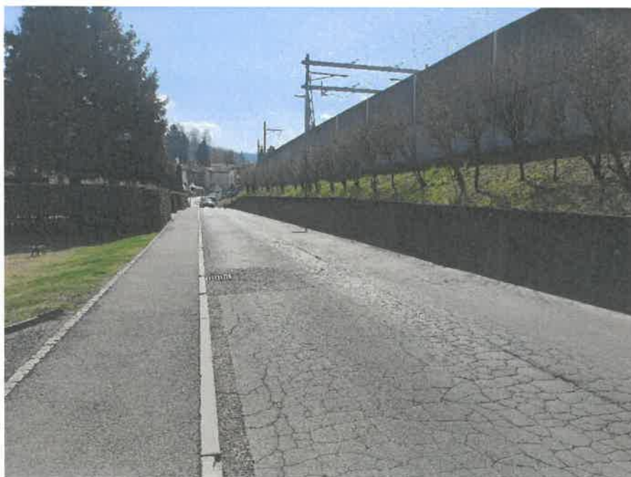
Foto 4 – Via alla Stazione parallela a binari FFS, muro di sostegno FFS, pali LC
