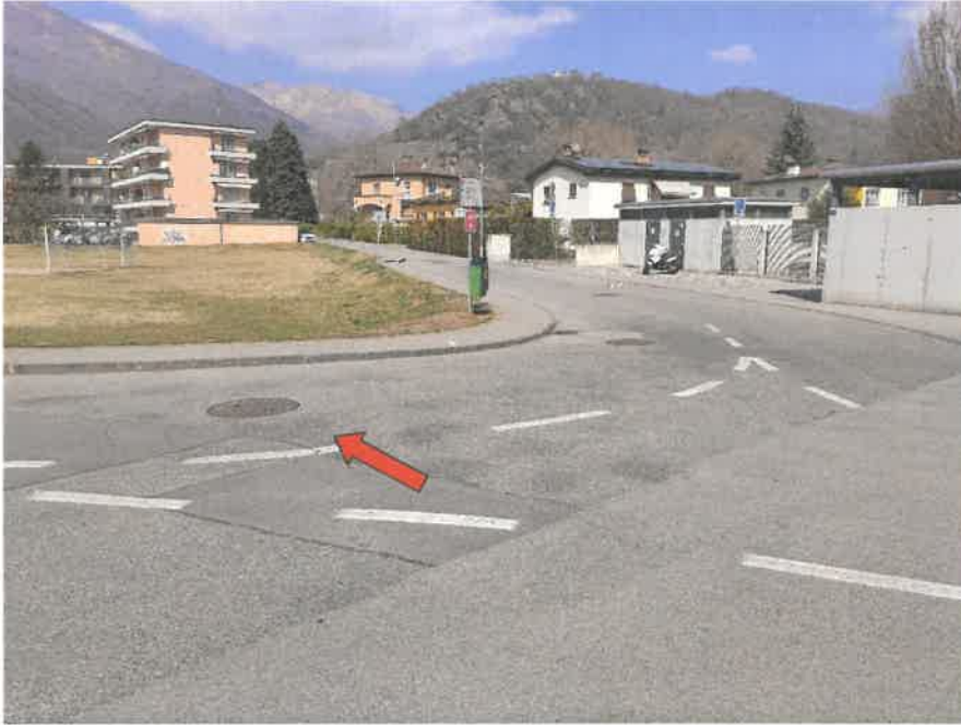
Foto 1 – Pozzetto di partenza N°. 47, via alla Stazione
