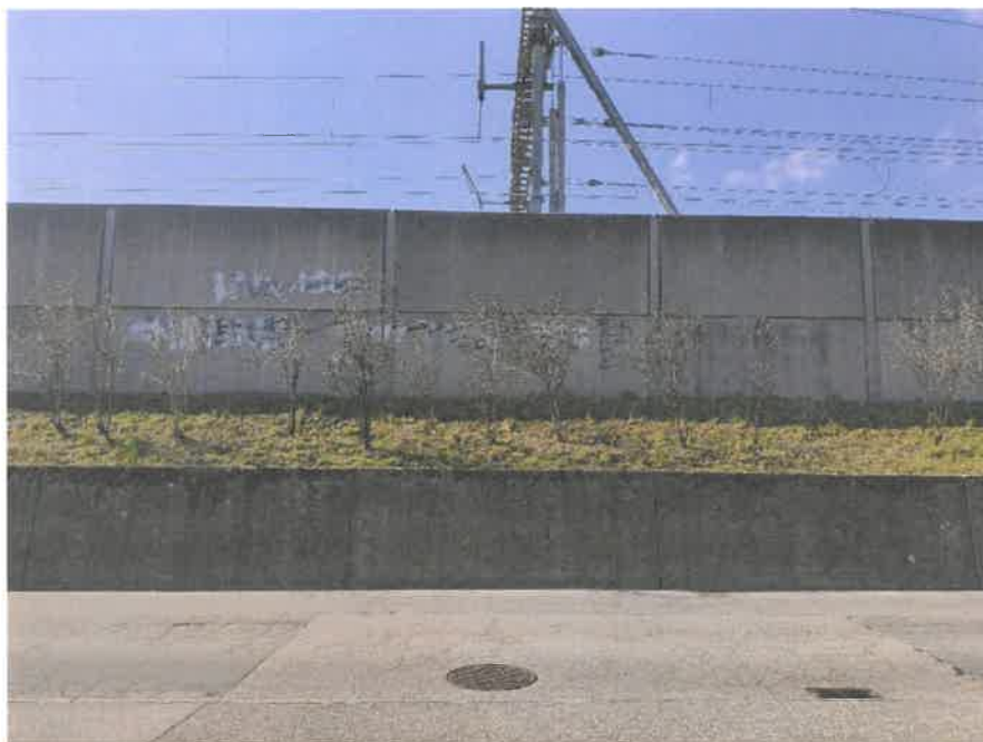
Foto 5 – Punto di attraversamento con spingitubo, Pozzetto N° 51, Via alla Stazione
